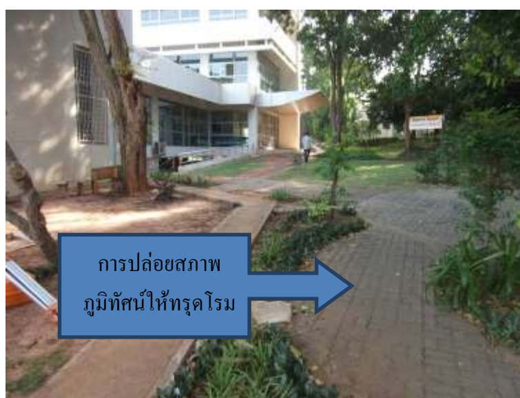
รูปที่ 4.8 สวนสาธารณะที่ต้องปรับปรุง (พื้นที่การปรับปรุงโซน B)
